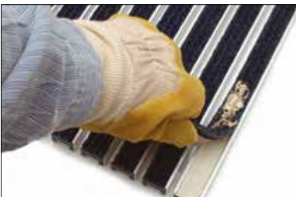
Décoller le reps d'un côté (à l'aide d'un tournevis par ex.) et arracher la bande endommagée sur toute la longueur.
